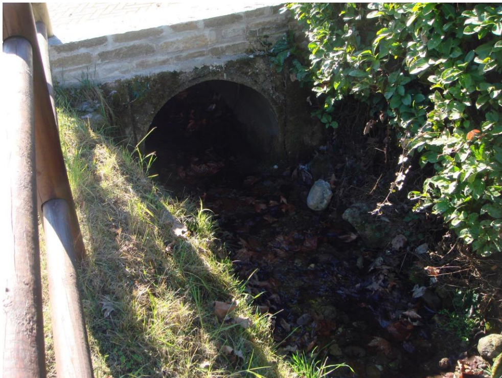
Foto MF14 – Molino Frattino: valle di Nâves, tratto intubato immediatamente a valle del punto di tracimazione (cfr. Foto MF10) avente sezione di deflusso insufficiente
