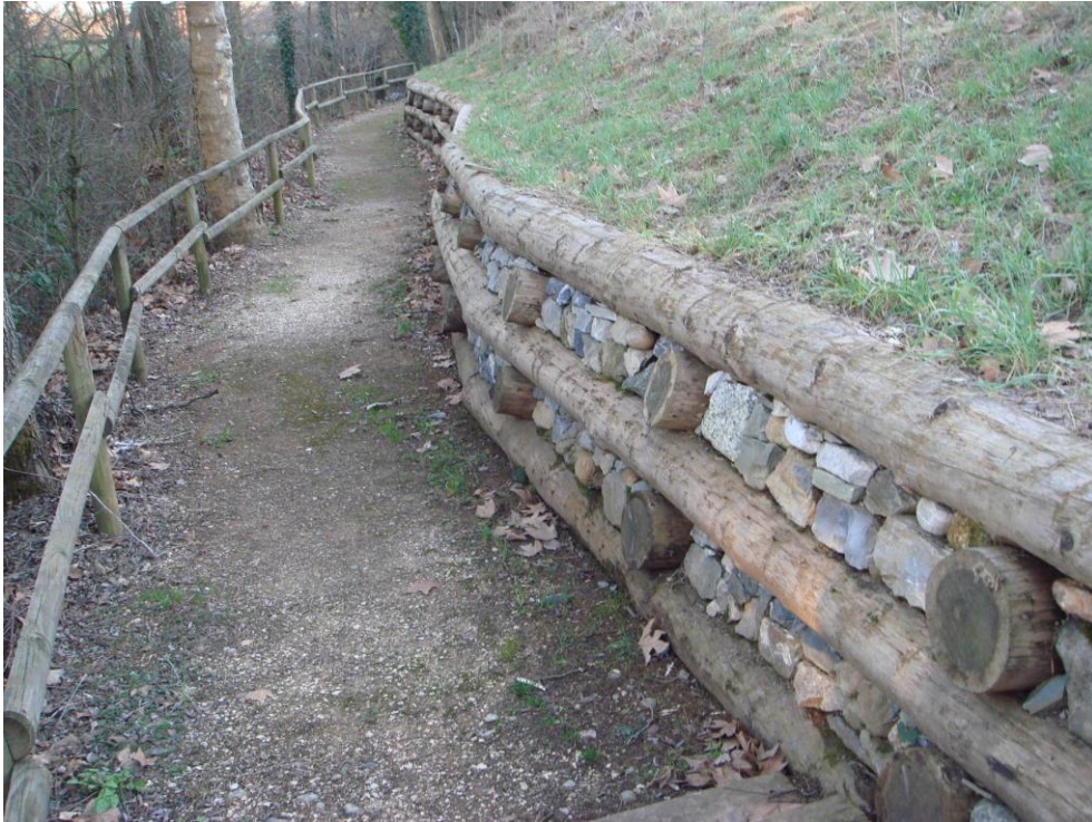
Foto BT7 - Frana via Butto: intervento di stabilizzazione/messa in sicurezza a valle di via Butto
