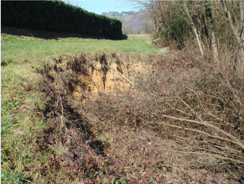
Foto BR5 - Frana Cascina Brughiera: vista del coronamento frana attiva sul pianalto immediatamente a valle del nucleo rurale
