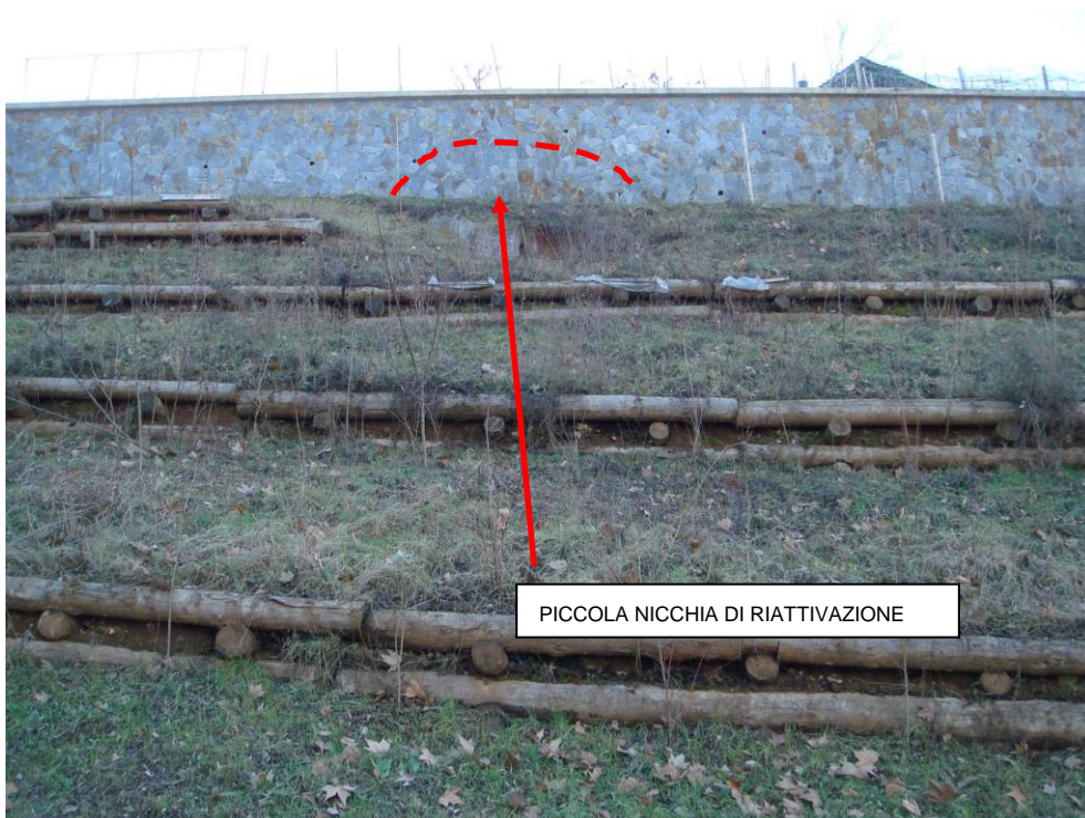
Foto BT3 - Frana via Butto: intervento di stabilizzazione/messa in sicurezza con piccola riattivazione del dissesto superficiale
