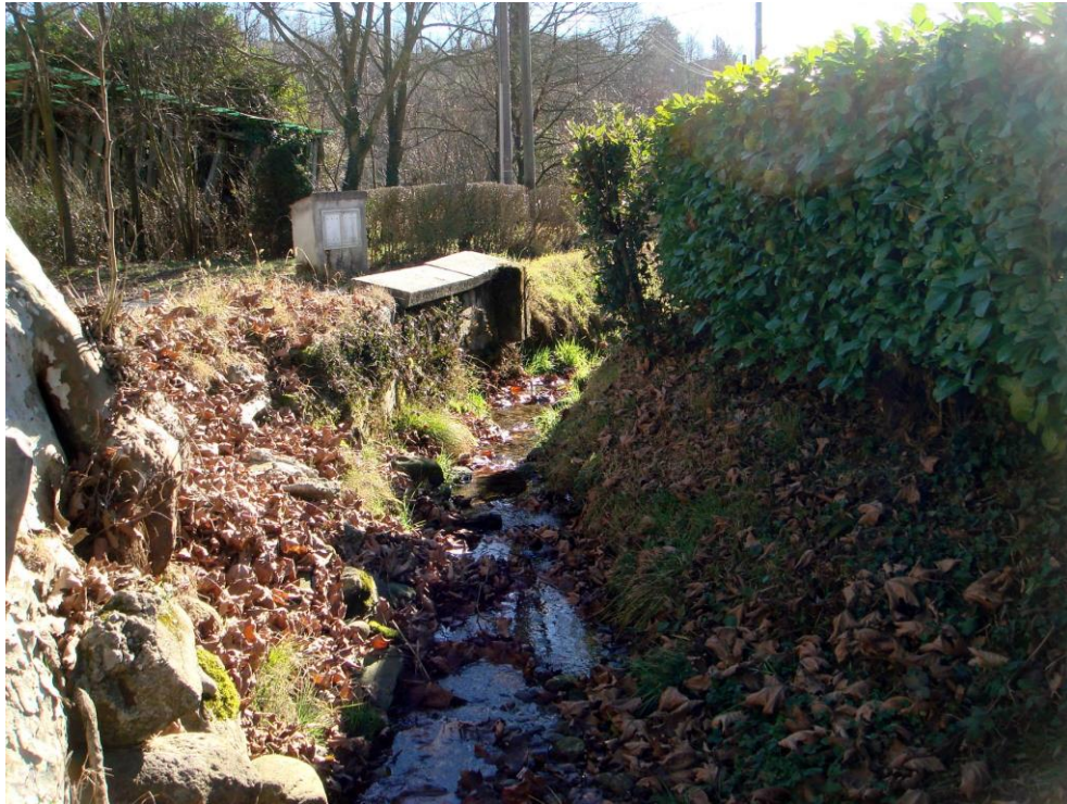
Foto MF10 – Molino Frattino: valle di Nâves, sezione di deflusso insufficiente e punto di tracimazione in corrispondenza della sponda idrografica sinistra
