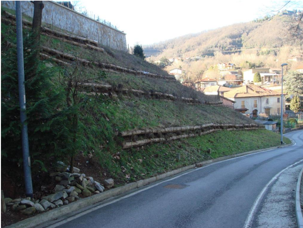
Foto BT2 - Frana via Butto: intervento di stabilizzazione/messa in sicurezza con interventi di ingegneria naturalistica. Collettamento di acque meteoriche al di sotto della strada con recapito nel T. Molgoretta a valle del ponte stradale
